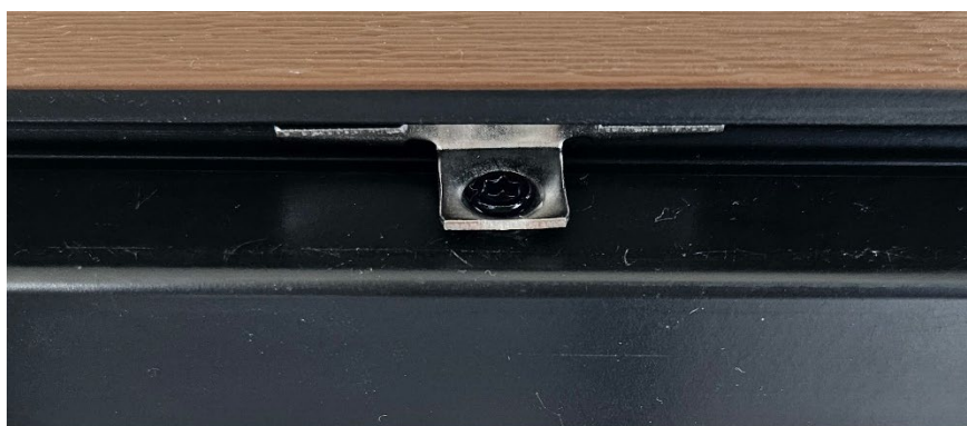
Montaż deski z klipsem do legara
